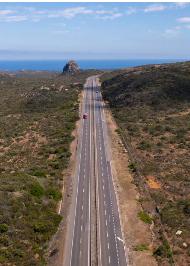
AUTOPISTA NUEVA ACONCAGUA | víaschile
